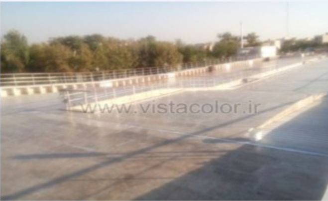
پروژه عایق کاری پارک مینیاتور تهران
