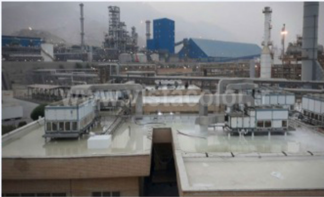
اجرای باکیفیت انواع عایق رطوبتی پلیمری در پتروشیمی پردیس عسلویه
