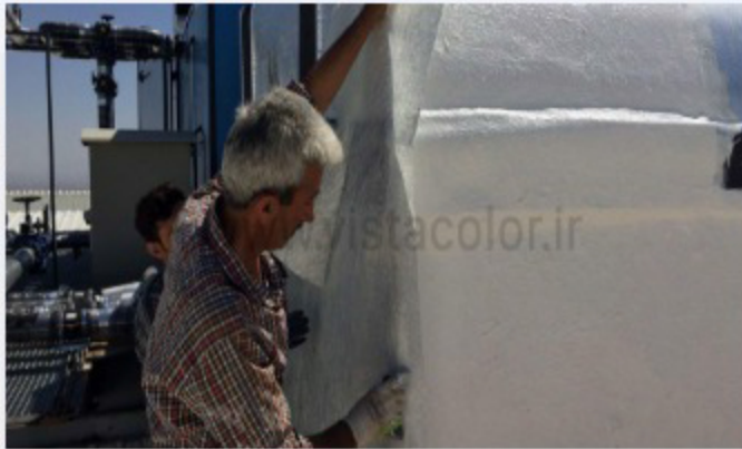
اجرای عایق های رطوبتی الیافدار بر روی کانالهای کارخانه سیگار اسکار در شهرک صنعتی کاوه
